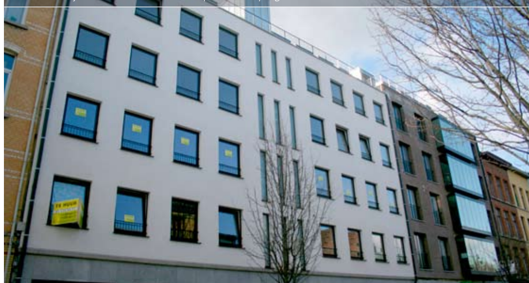
Het nieuwe schrijnwerk bestaat uit SP50- en SD50-profielen van Sprangers.
